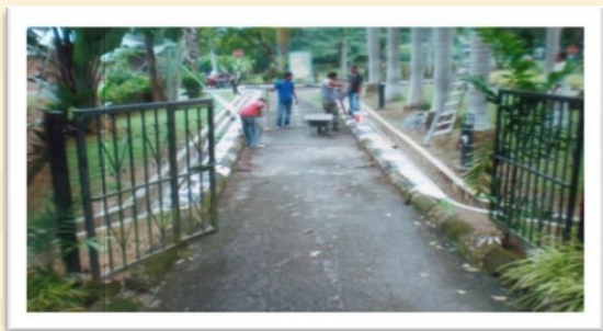
Sebelum Kerja-kerja Dijalankan
